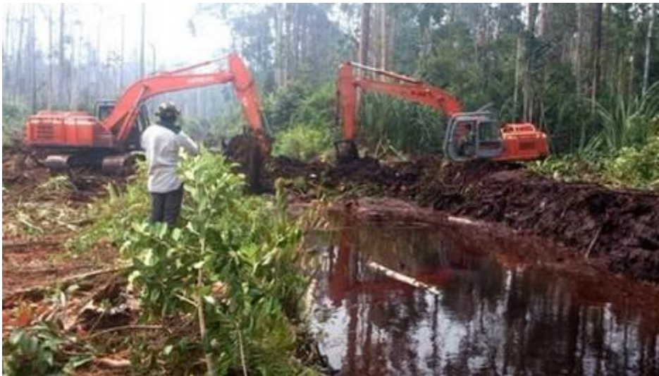
Keterangan: Pembuatan sekat gambut untuk merestorasi hutan HTI di area Sembilang, Sumatera Selatan
